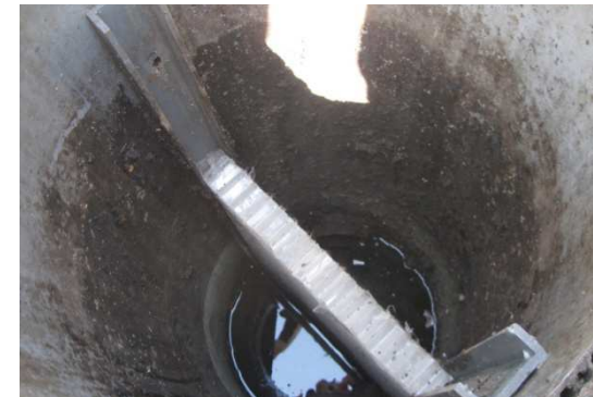
Filtres dans les boîtes de branchement
