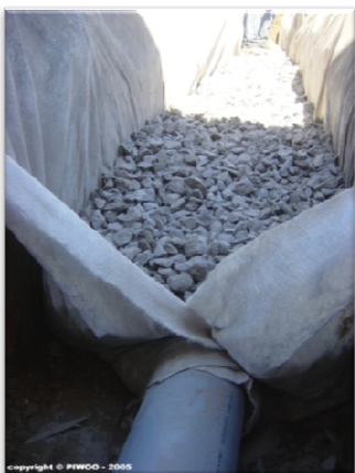
Des tranchées drainantes
