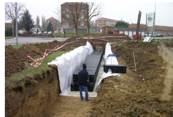
Tranchée drainante en SAUL (Indice de Vides : 95%)
