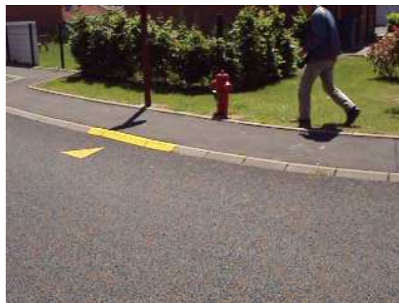
Une chaussée à structure réservoir avec enrobés poreux
